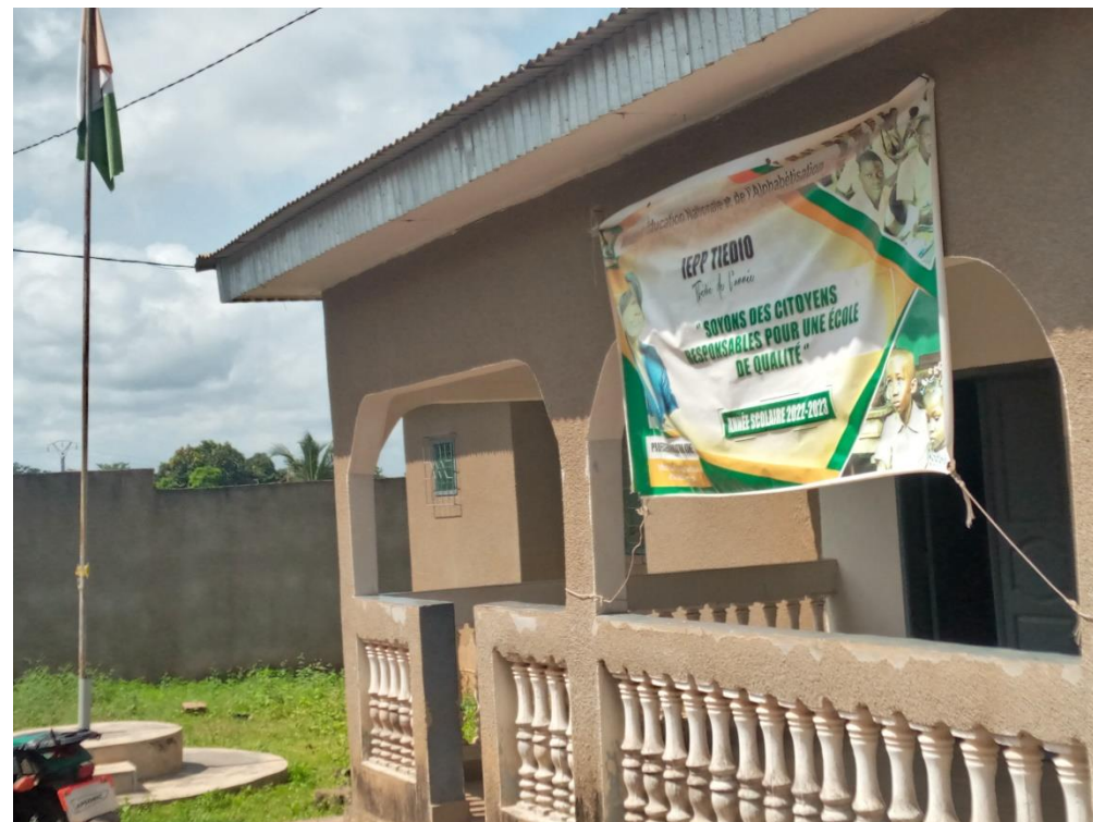
Une vue de la façade de l'inspection de TIEDIO
